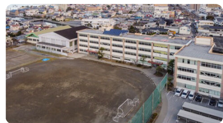
旧館山中学校 校舎・グラウンド
