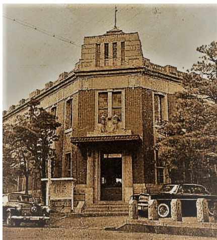
館山市役所分館(昭和31年)
