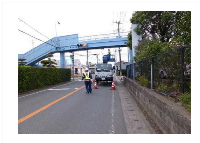
写真-1 定期点検の状況
