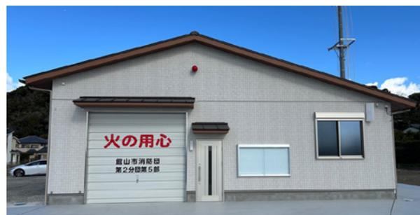
亀ヶ原地区を担当する、市消防団第2分団第5部の詰所を新築し、2/15から運用を開始しました。旧詰所は、令和元年房総半島台風の被災や老朽化が著しく、亀ヶ原区の増田納之氏より建て替え用地を無償貸与いただいたことから、耐震性・居住性が確保された詰所が完成しました。
