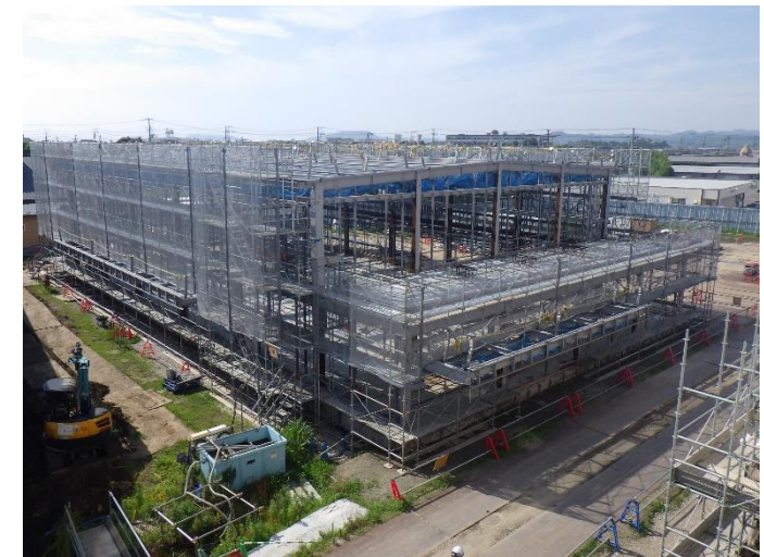
第二体育館（鉄骨工事完了・外壁工事前仮設足場設置）
