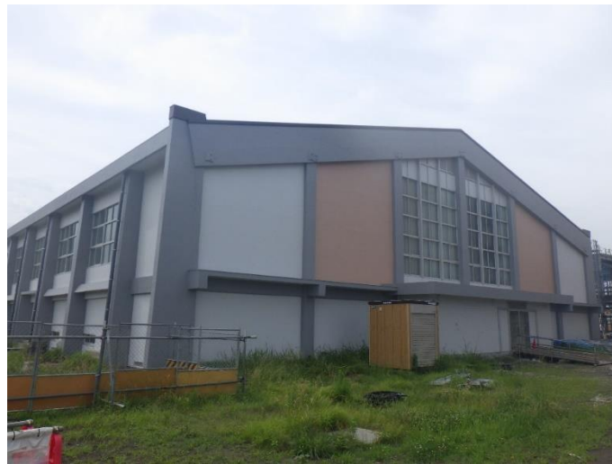
第一体育館（旧三中体育館）（正面）
