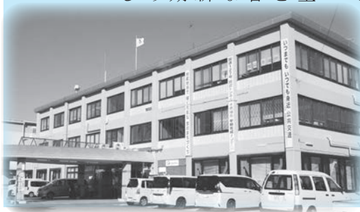
築60年を経過した現庁舎
