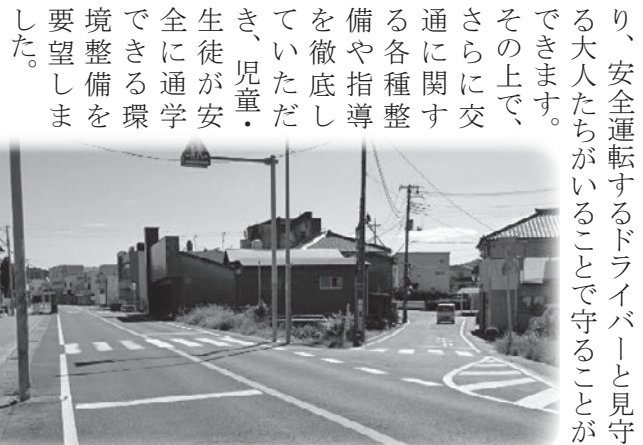
国道 410 号と市道の交差点（踏切付近）
