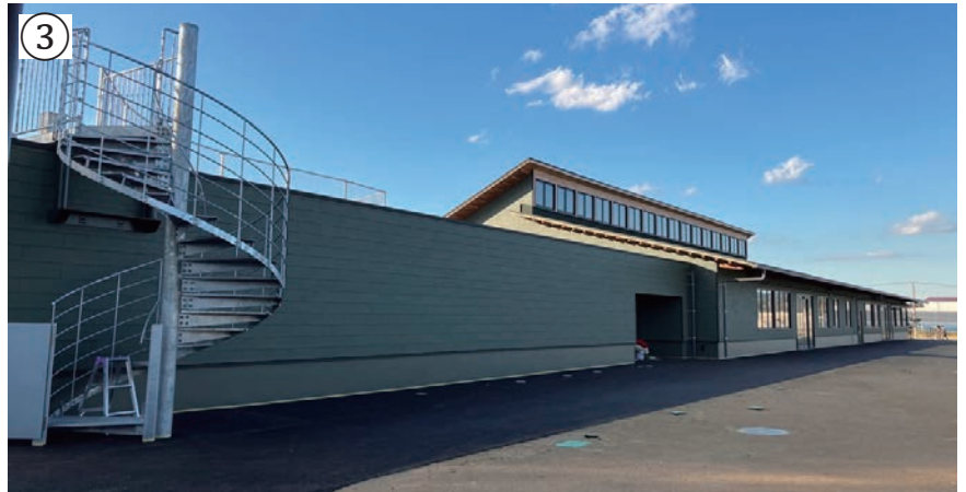
▲〈建物南東側から〉陸屋根に上るらせん階段を設置
