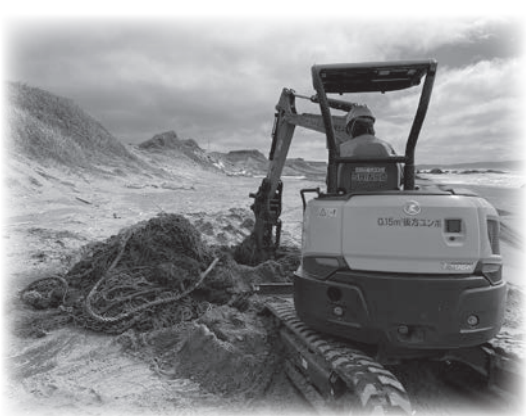
重機による海岸清掃 (R4.10 平砂浦海岸)
