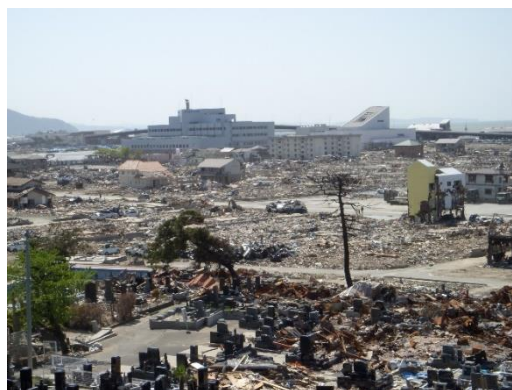
【写真：宮城県石巻市の津波被害】
