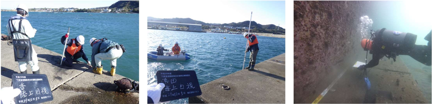
左：陸上調査状況、中：海上調査状況、右：潜水調査状況
