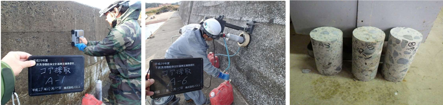
左：鉄筋探知状況、中：コア採取状況、右：コアサンプル
