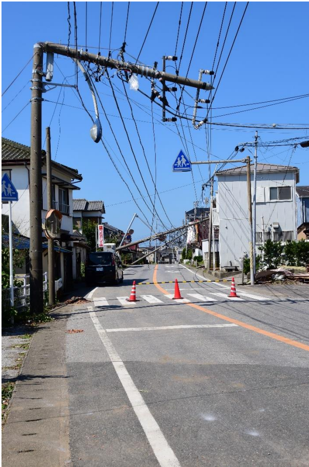
倒れた電柱（船形地区）
