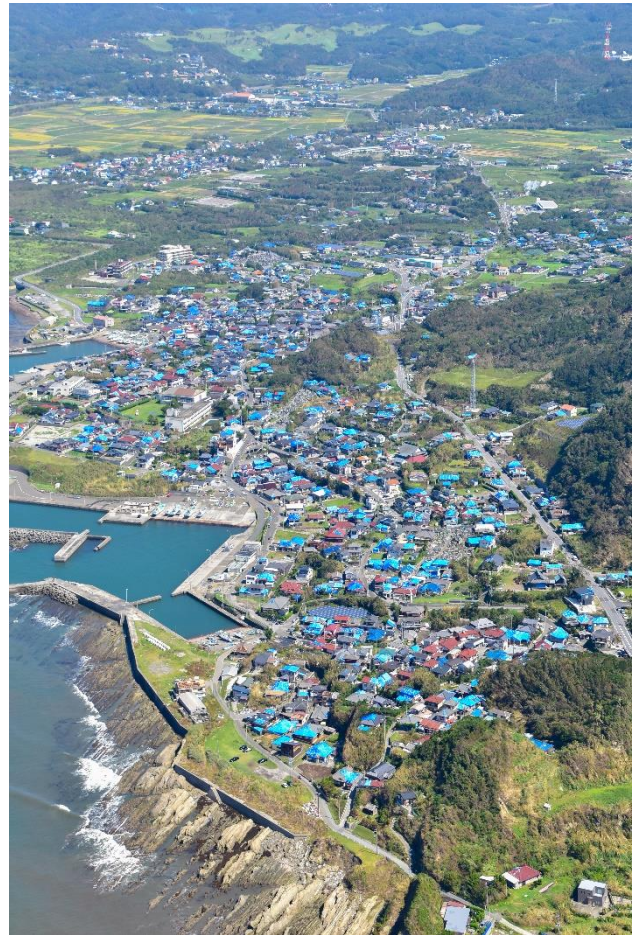
ブルーシートに覆われた家屋（富崎地区）
