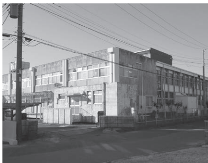
館山市学校給食センター
