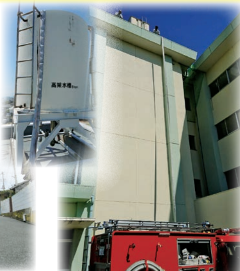
停電の学校屋上水槽へ送水 9/10
