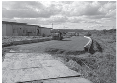
二子地区市道9052号線整備状況
