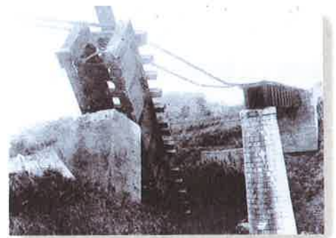
地震でくずれた鉄橋(九重千倉間)
