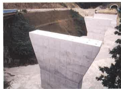
工事中の富津館山道路 (富浦町)
