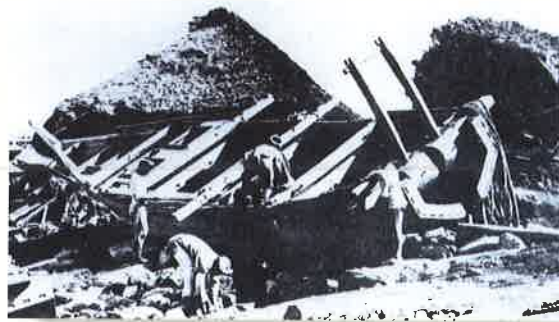
津波の被害（布良）
