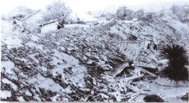
安房高等女学校（安房南高）の倒壊
