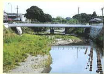
横峯大橋 (旧岩崎橋) 付近 (上流)
