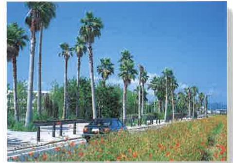
国道127号館山バイパス（北条小付近）
