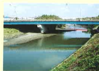
平成橋付近 (下流)
