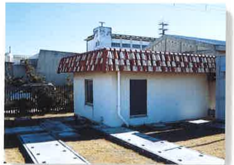
排水路浄化施設(汐入川河口)
