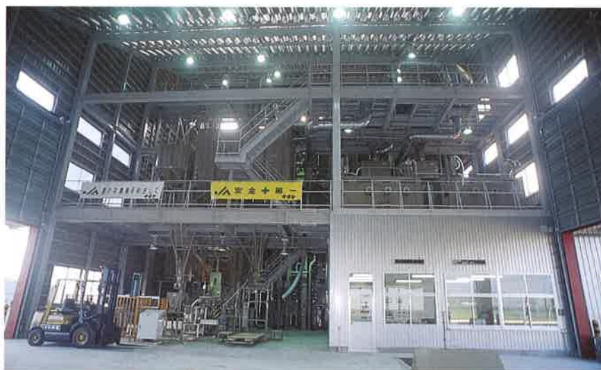
館山ライスセンター内部
