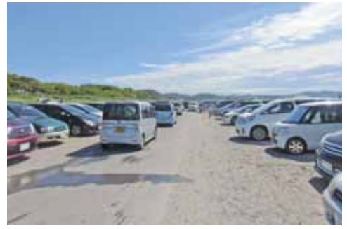
沖ノ島の駐車場の整備状況
