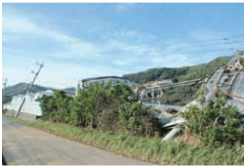
台風18号による被害状況
