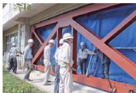
小学校の耐震改修工事
