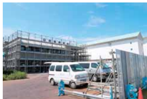
建設中の「渚の駅」たてやま商業施設棟
