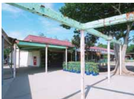
耐震改修予定の北条小学校低学年棟
