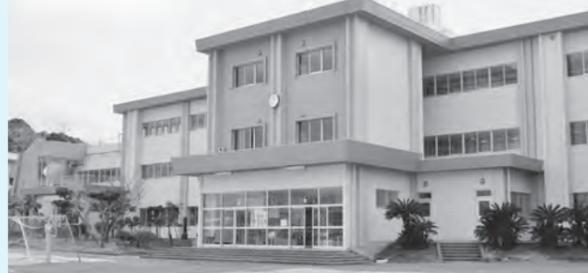
両校舎は、昭和50年台半ばに建築され、耐震診断の結果、補強を要するとされたもので、今回の工事で鉄骨ブレースなどで補強するとともに、老朽化した外壁や内装、トイレの改修などを実施し、児童・園児にとってより良い環境となりました。
