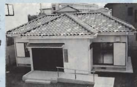
完成した六軒町7町内会集会所
