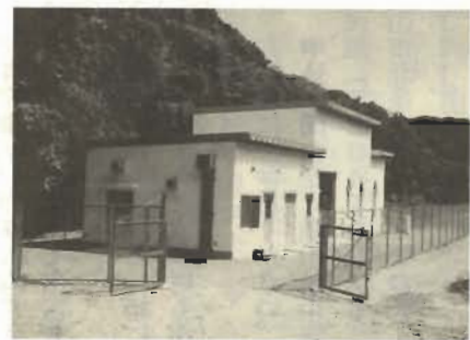
浸出水処理施設
