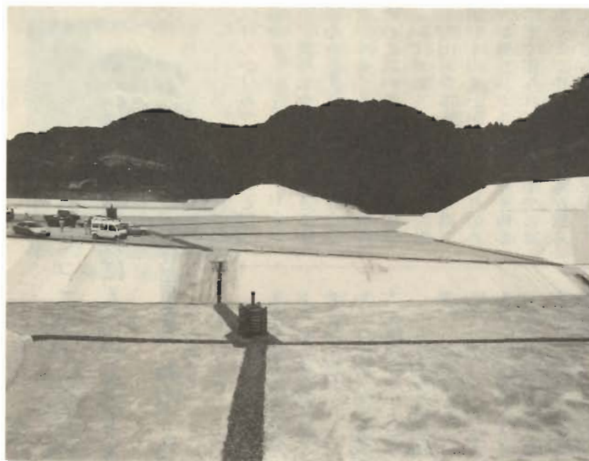
かさ上げ工事が完了した一般廃棄物最終処分場
