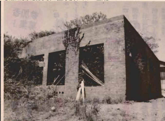
●館山海軍砲術学校の機関場(ボイラー室)跡
