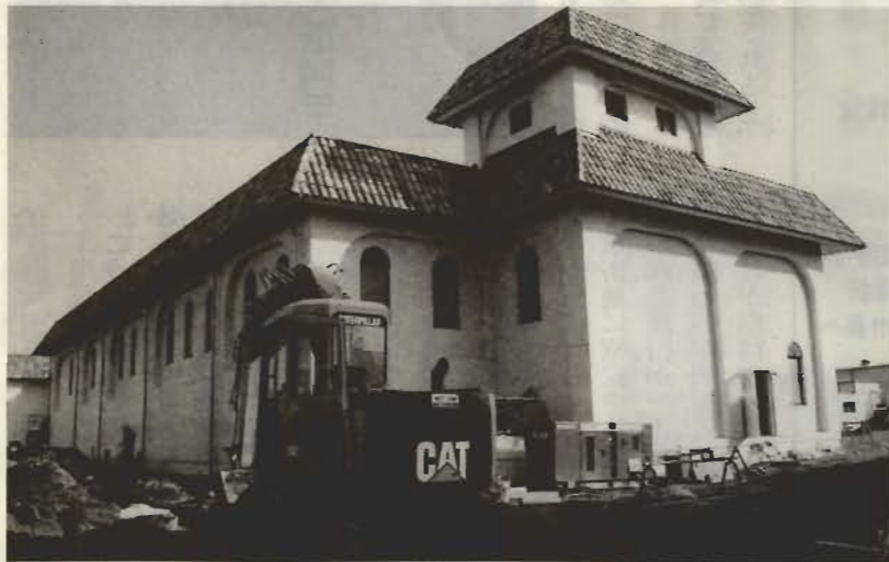
●供用開始にむけ、場内整備などの工事が進む。
