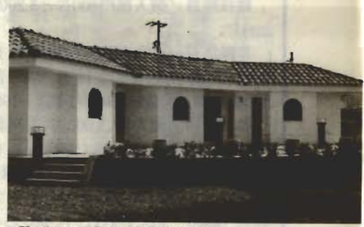
▲那古海岸に完成した南欧風公衆トイレ。植栽も施されちょっとした休憩施設にもなります。
