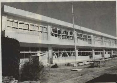
▲改修された豊房小学校校舎
