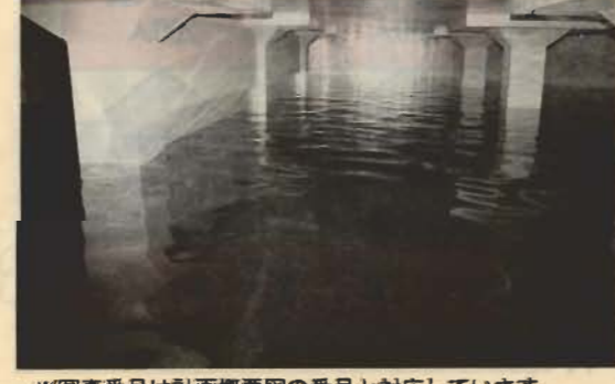
▼●出野尾配水場(館野市) 貯水槽の中、貯水量は4,300m 3 、25mプールの約10倍です。企業団からの水道水を受水します
