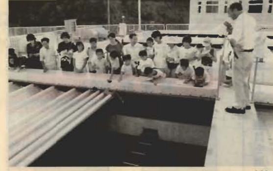
▼●出野尾配水場(館野市) 貯水槽の中、貯水量は4,300m 3 、25mプールの約10倍です。企業団からの水道水を受水します
