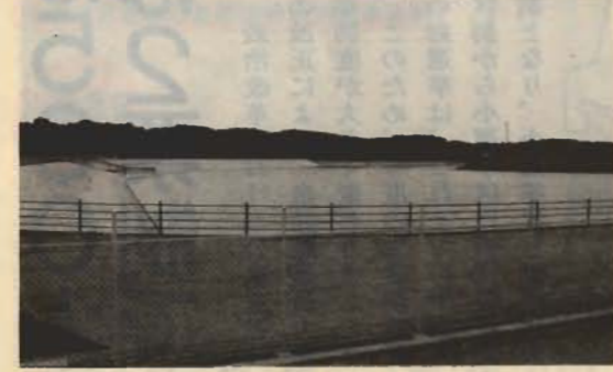
▼●大多喜浄水場(大多喜町) 利根川の水を消毒処理して水道水を作ります
