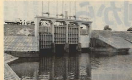
▼●横芝揚水機場(横芝町) 栗山川に導水された利根川の水を送水管に送りこみます
