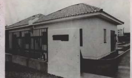
白壁にオレンジ色の屋根瓦をのせ南窓の外観に仕上げられた那古地区生活排水処理施設
