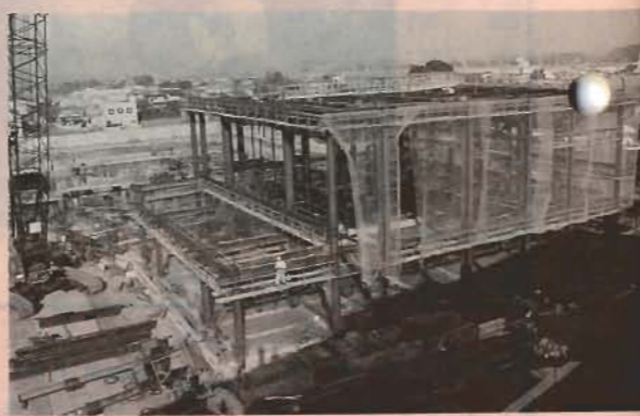
▲コミュニティセンター隣接地に建設中の県立南地域文化ホール(仮称)
