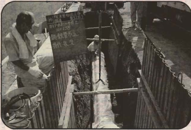
水需要の増大に対処、配水管布設工事が進む▲
