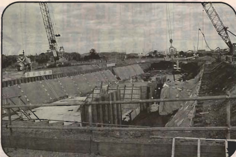
水処理施設の建設が進む鏡ヶ浦クリーンセンター▲
