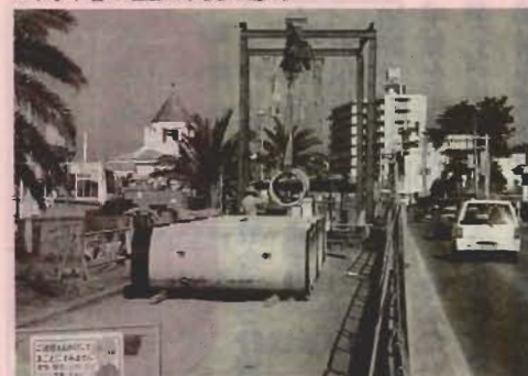
▼下水本管の埋設工事(海岸通り)
