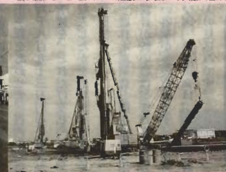
▼鏡ヶ浦クリーンセンターの建設工事(奥・平久里川左岸)
