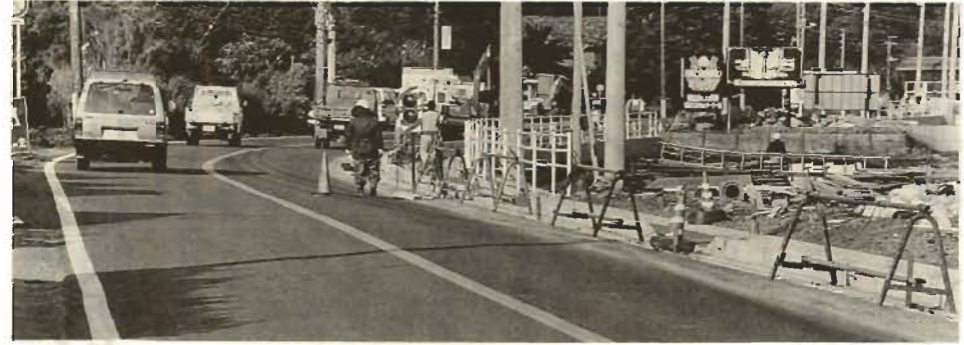
歩道整備が進められている国道410号（洲宮地区）
