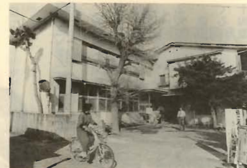
改築が予定される婦人会館
