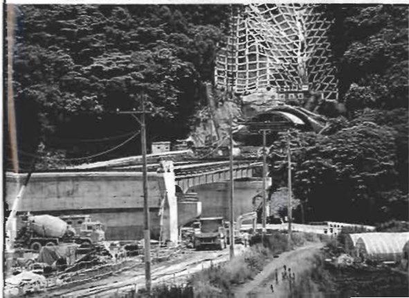
橋、トンネル工事が進む127号高規格道路
