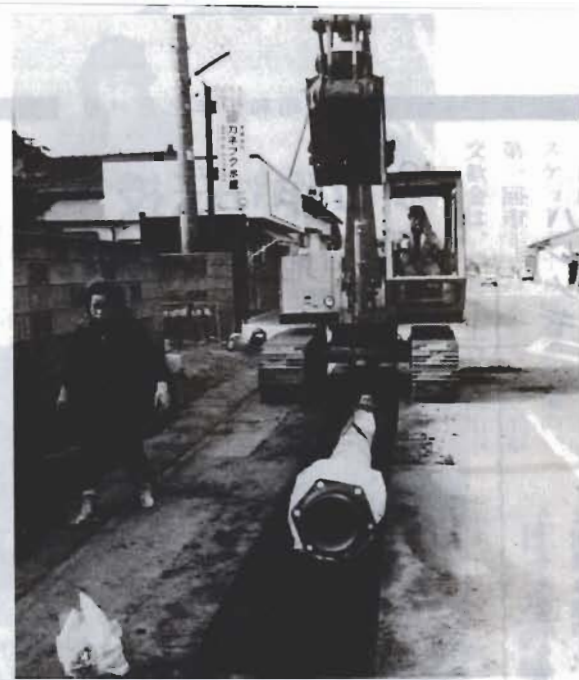
次々に埋設される配水本管
