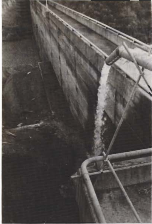
乾ききったダムへ取水（増間で）
