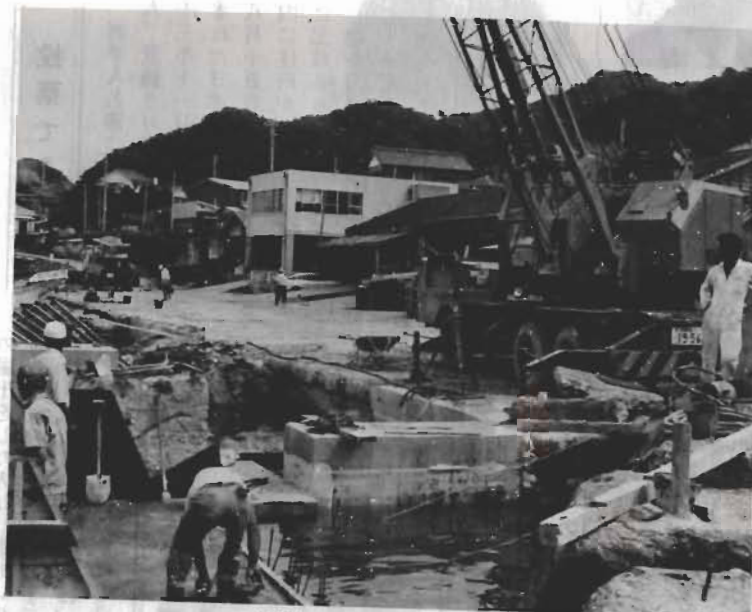
▲岸壁の工事が進む富崎港
