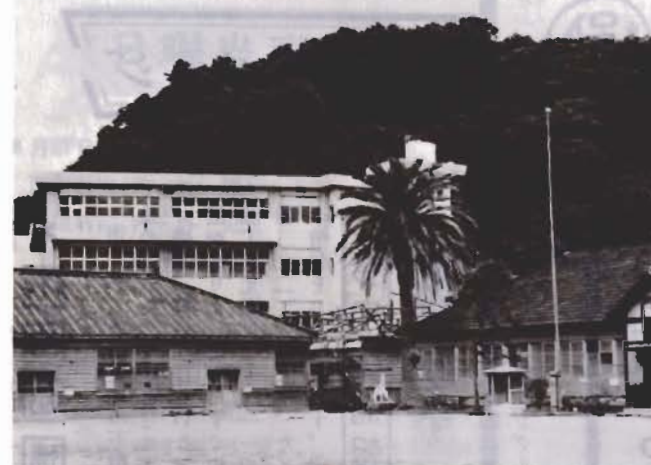
解体工事の進む那古小
