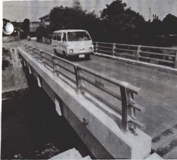
コンクリート橋になり、自動車も通れるようになりました。
