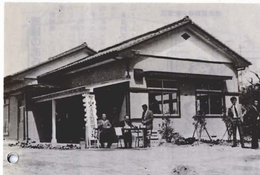
▲完成した山本青年館 所在地＝山本804番地
