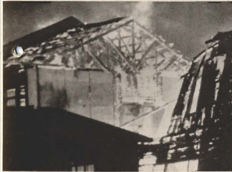
▲恐ろしい建物火災(旧一中)
