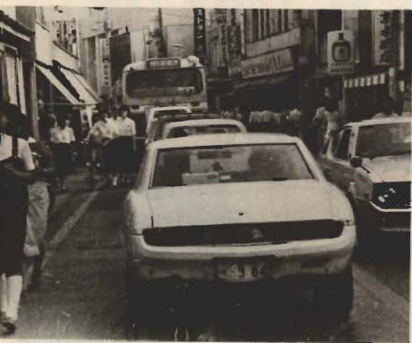
混雑する国道 現在の国道は、築華街を通るので、混雑・渋滞は毎日のこと。どうしてもバイパスが必要だ
