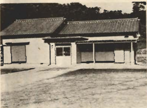
▲完成した安東青年館
