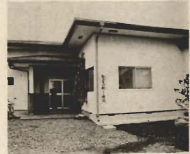
↑完成した公民館館野分館
