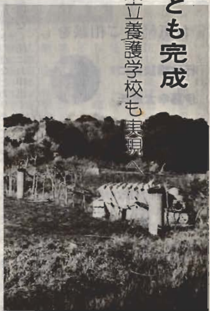
▲神戸中里の県立養護学校建設予定地
