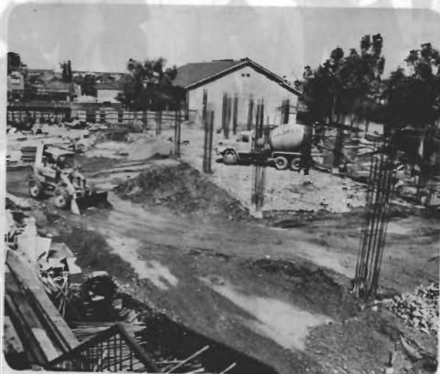
↑工事が始まった第二中学校防音校舎
