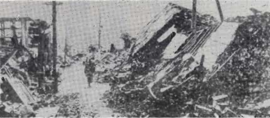
家屋倒壊 (館山町地区)
