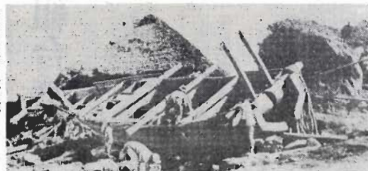
富崎村布良附近 家屋、漁船の破壊状況
