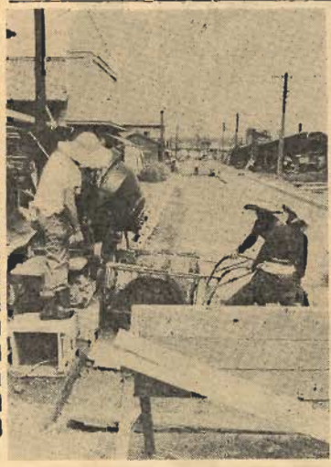
館山漁港前と新塩場の舗装工事
