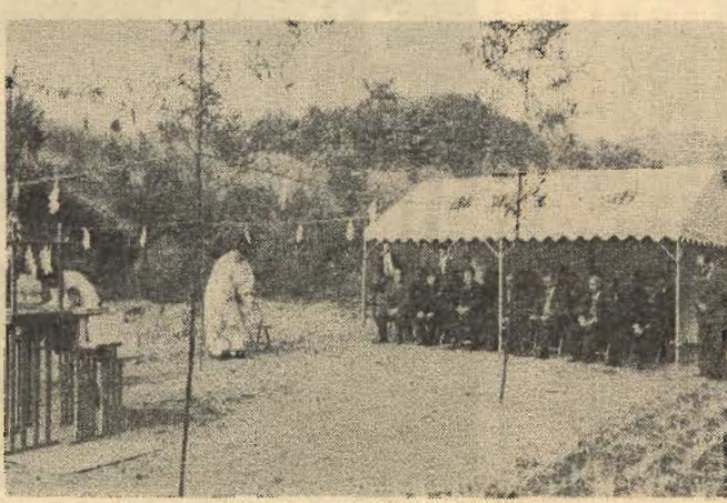
写真=衛生処理場の起工式
