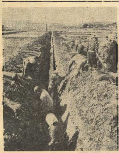
写真=南条の作業現場
