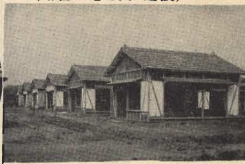
(市営住宅 20 戸建設)
