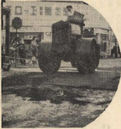
(古茂口地先の暗渠事業)
