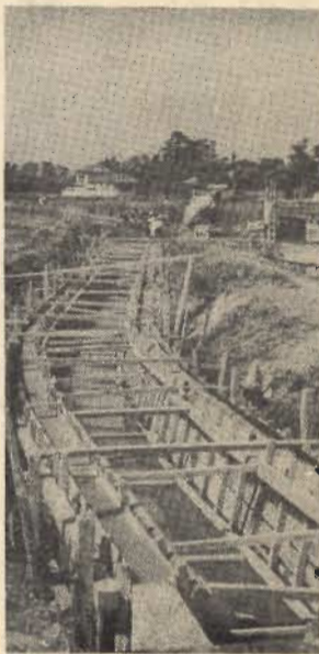
(中央排水路工事)
