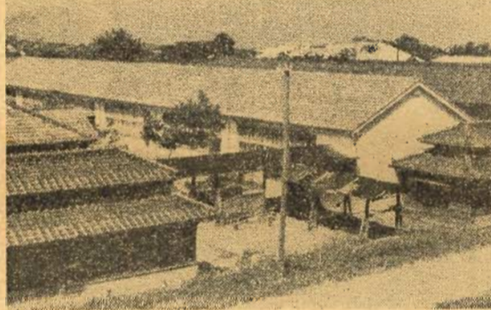
焼失した館山小校舎 完全に復旧工事成る
